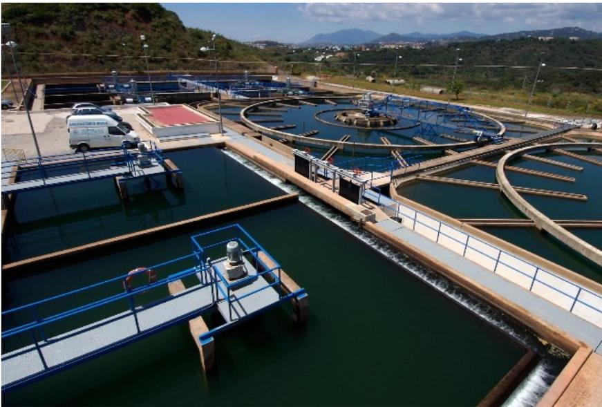
La instalación de aireación consiste en dos tanques rectangulares de 12 x 12 m y 3,50 m de altura de lámina de agua cada uno. En ellos están instaladas dos turbinas aireadoras superficiales. Cada turbina es capaz de mover un caudal de 1,15 m<sup>3</sup>/seg., pudiendo introducir 6 mg/l de oxígeno. Con esta instalación se consiguen eliminar, en parte, aquellas sustancias que puedan producir olor y/o sabor en el agua de consumo.
