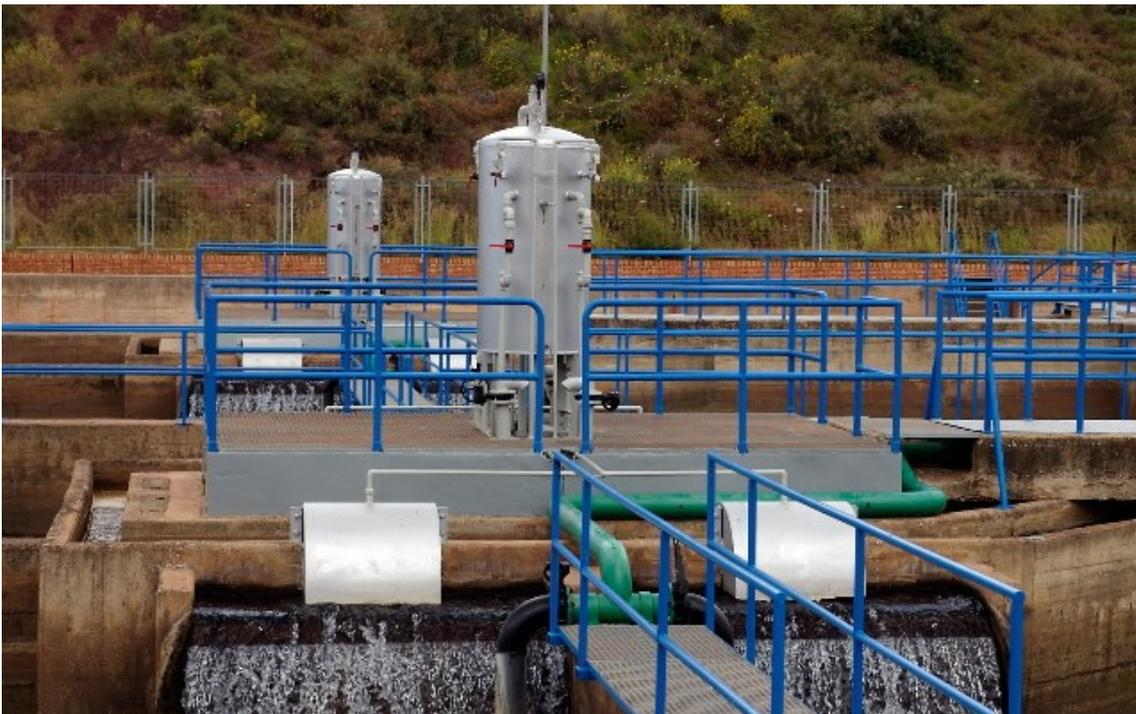
La filtración es también uno de los procesos importantes en el tratamiento de agua de consumo humano, el proceso, consiste, en hacer pasar el agua a través de un lecho filtrante de arena silíceo para eliminar los sólidos que no se hayan retenido en la decantación. La E.T.A.P. dispone de cuatro centros de filtración y cada centro dispone de cuatro celdas.
